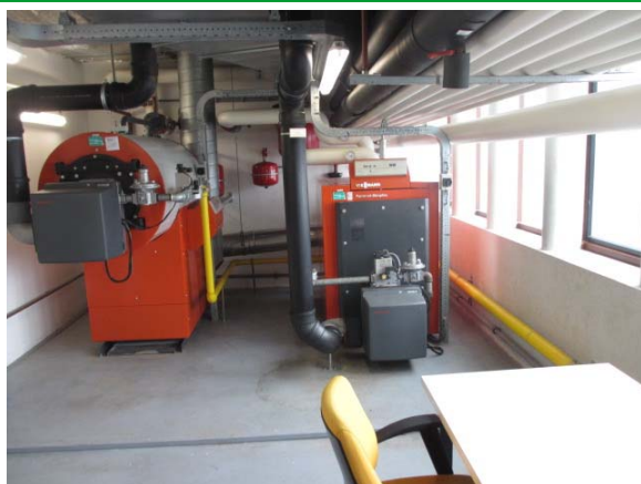
Technische ruimte met c.v.-ketels
